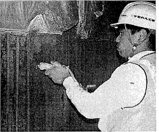
塩素イオンと反応する材料を鉄筋に吹き付ける (JR総研が開発した補修法の施工風景)
